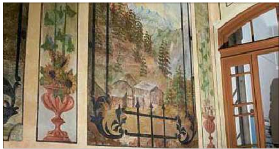
Malereien-Fund im Haus an der ul. Dąbrowszczaków 15
